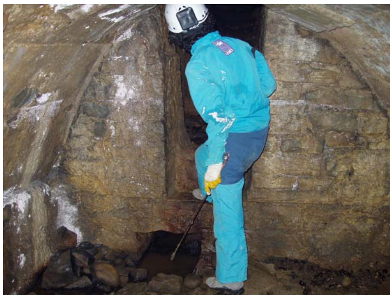
Colle Aperto – cameretta di raccolta delle sorgenti dell'acquedotto.
