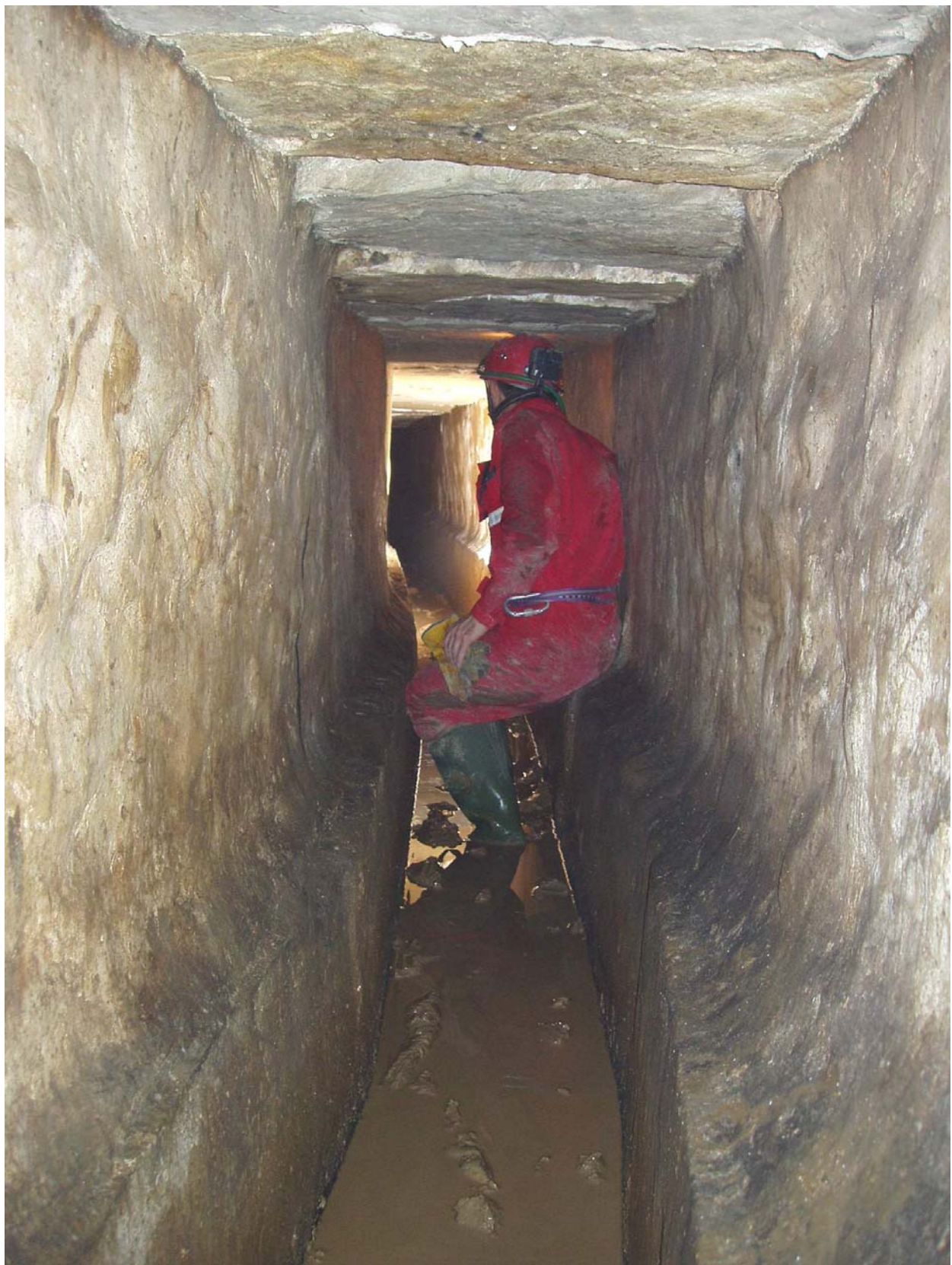
S. Agostino – tratto di canale dell'acquedotto di Prato Baglioni situato in prossimità delle abitazioni di via Fara.
