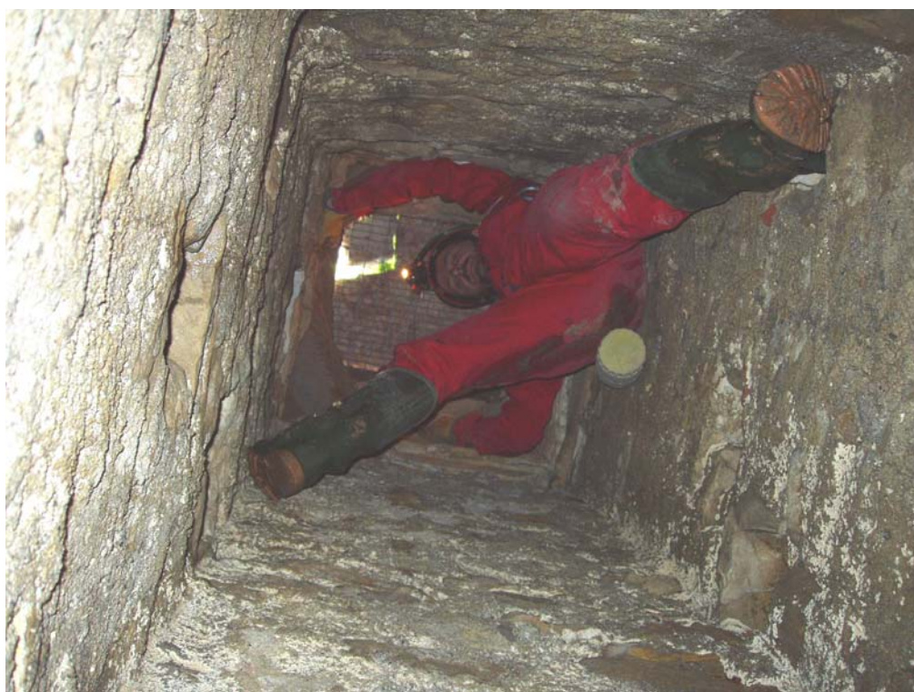
S. Agostino – pozzetto di accesso situato in prossimità delle abitazioni di via Fara.
