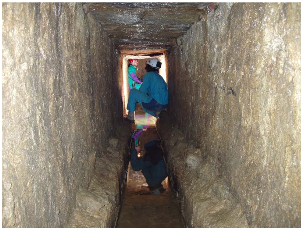
Porzione di acquedotto percorribile con accesso dall'interno della sortita della cannoniera della Fara.
